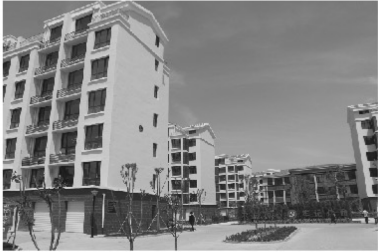
建设完成的武家村新居民小区
