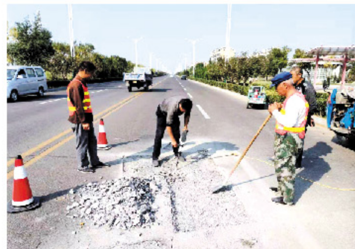
孙武四路路面维修
