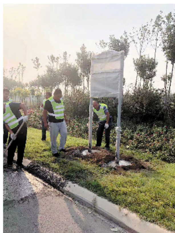
城乡公交客运站点施工
