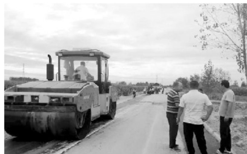
四好农村路施工
